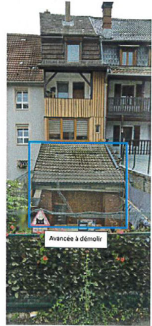
Avancée à démolir côté rue des Remparts
