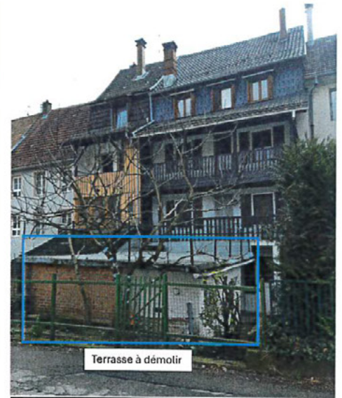
Terrasse à démolir côté rue des Remparts
