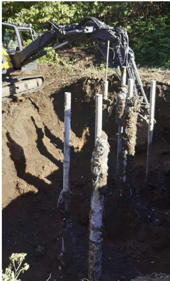
*Figure III.1 : Solution par micropieux*
