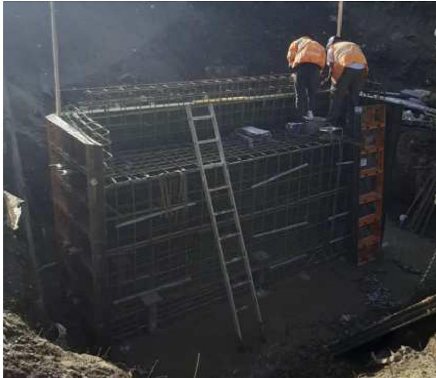
*Figure III.2 : Réalisation de culée en béton pour assurer l'assise de la passerelle*
