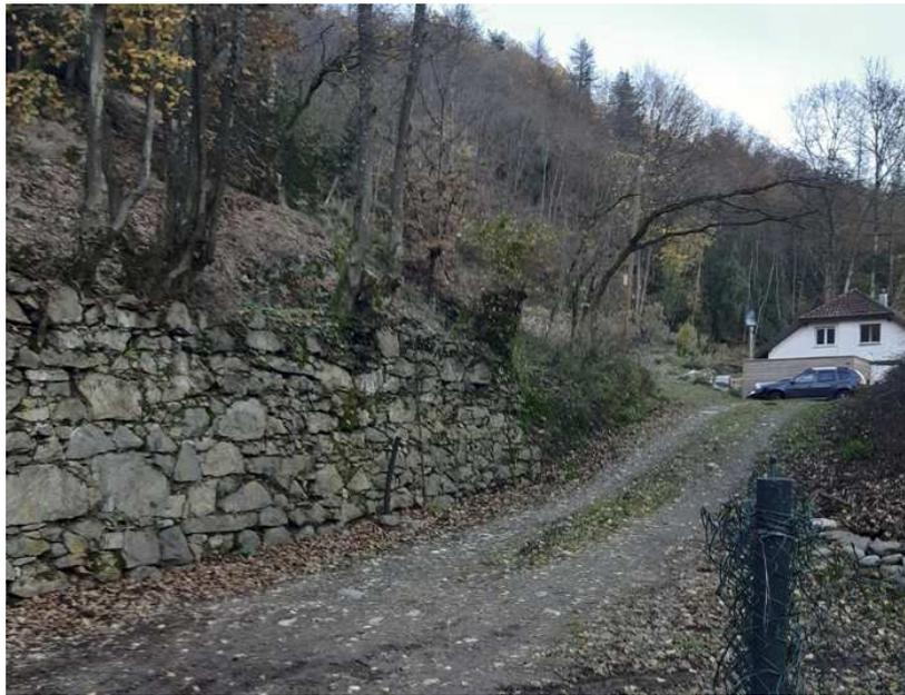
*Figure III.5 : Remblais contre le mur du riverain*
