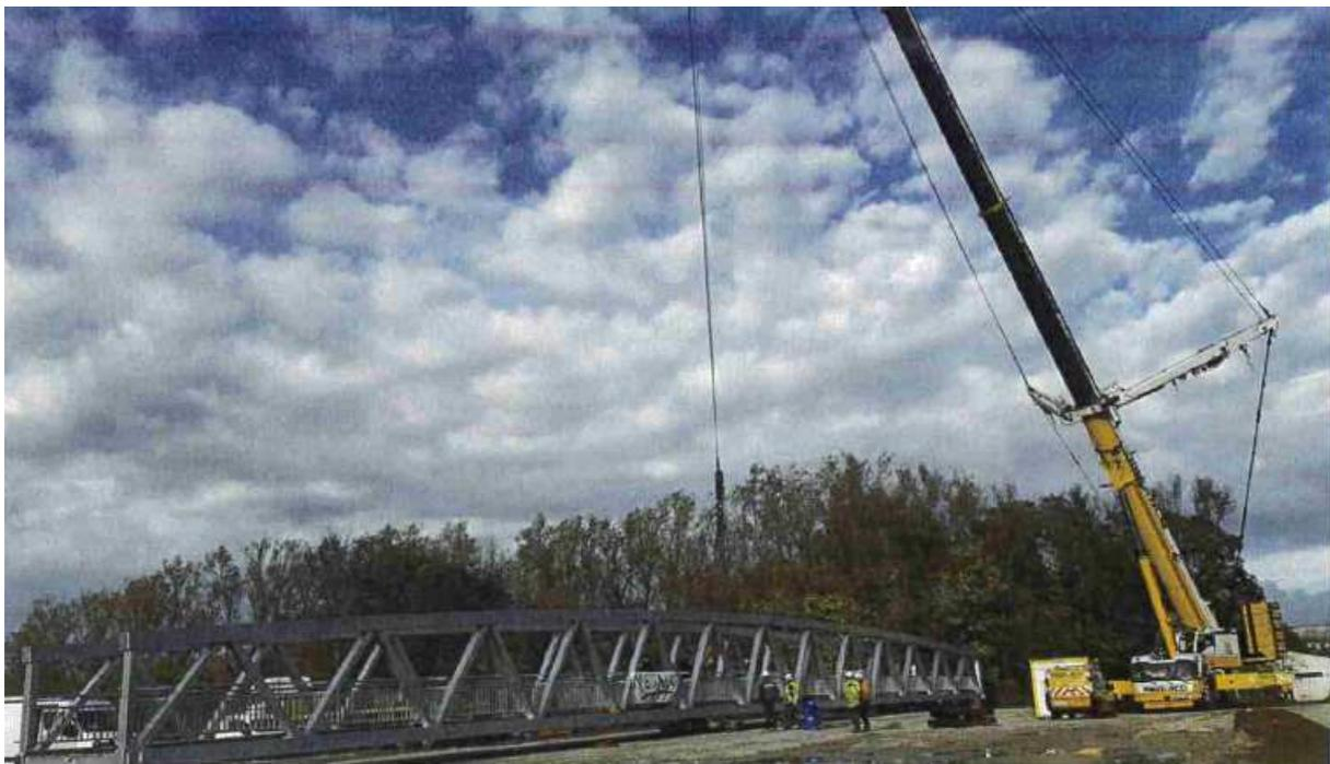
Figure IV.1 : Exemple d'une grue mobile et de la pose d'une passerelle cyclo-piétonne de 45 ml
