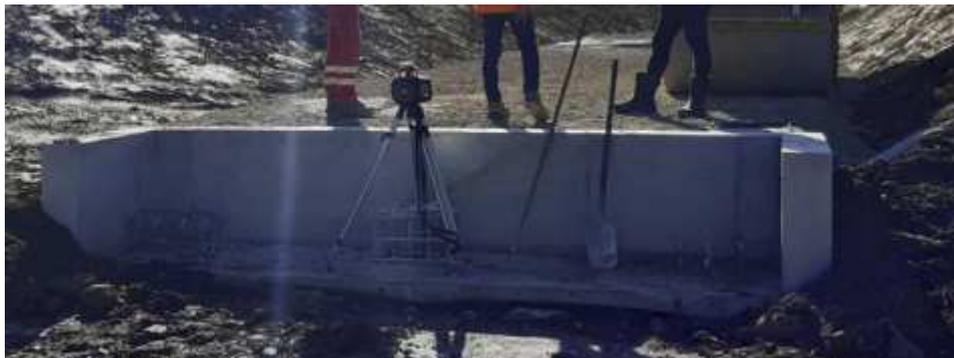
*Figure III.3 : Exemple d'une culée bétonnée*
