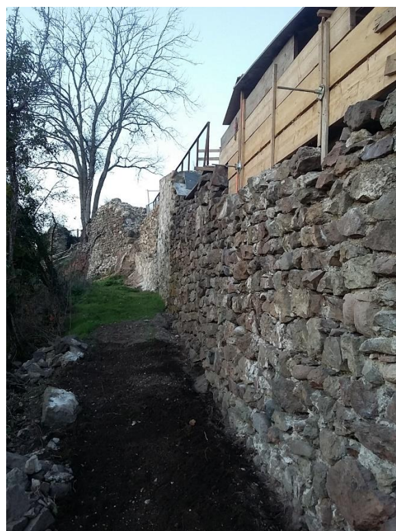
Remparts Sud – travaux 2020
