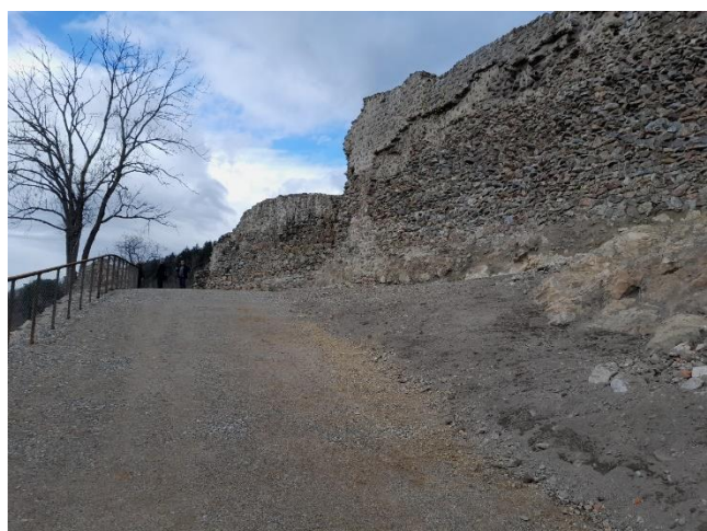
Remparts Sud – suite restauration en 3 tranches 1997 – 2023
