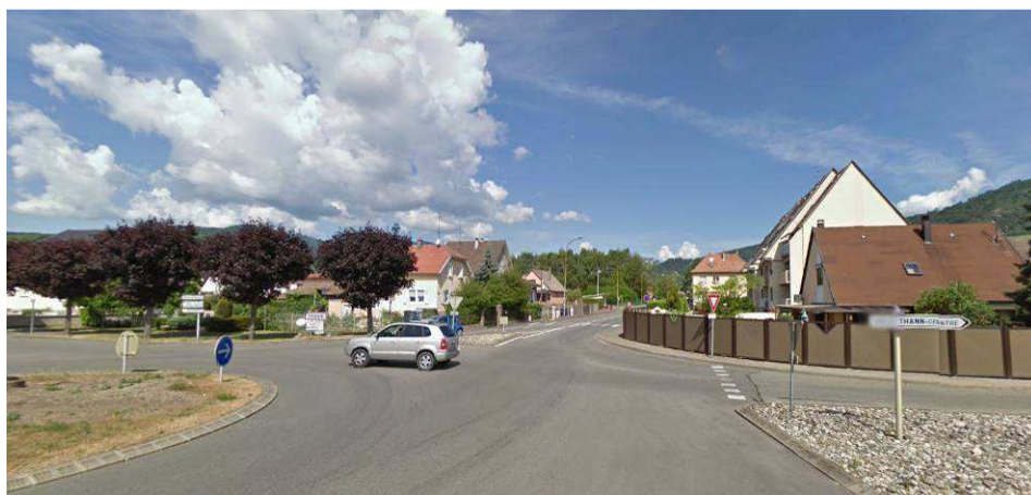
Entrée Sud-Est par la RD 103 (en venant d'Aspach-Le-Haut)
