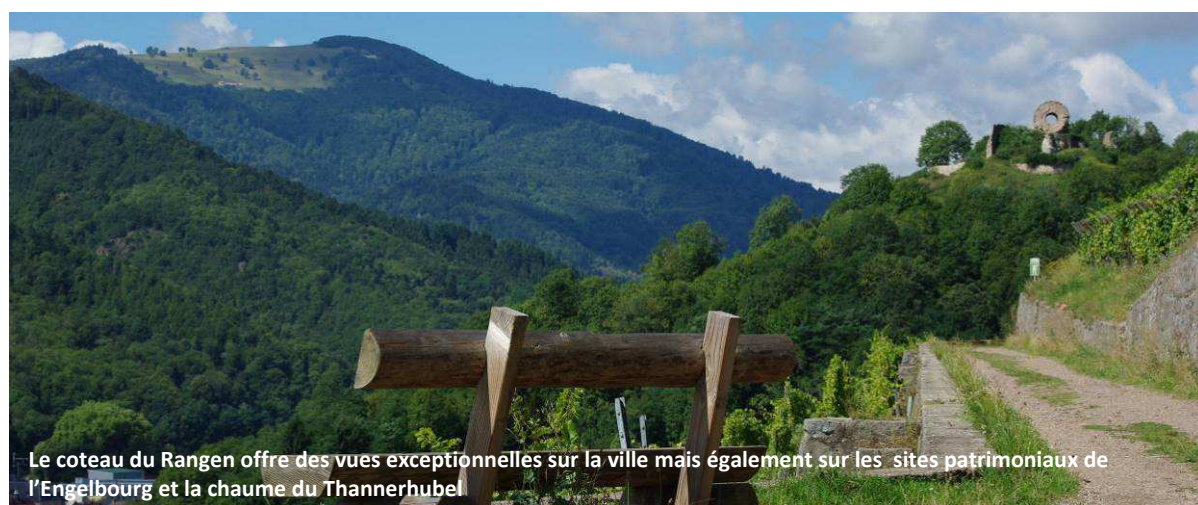
Point de vue remarquable depuis le château de l'Engelbourg sur la vieille ville, la collégiale et les extensions récentes en direction de Leimbach
