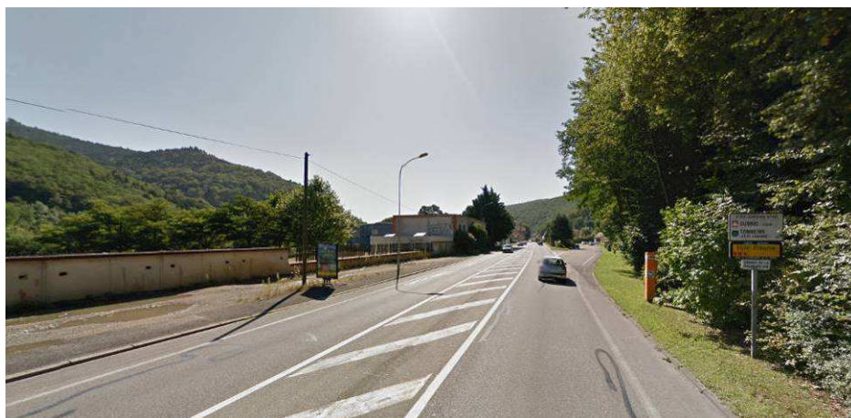
Entrée Nord par la RN66 (en venant de Bitschwiller-lès-Thann) A banale
